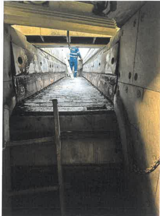
Демонтированные футеровок.
